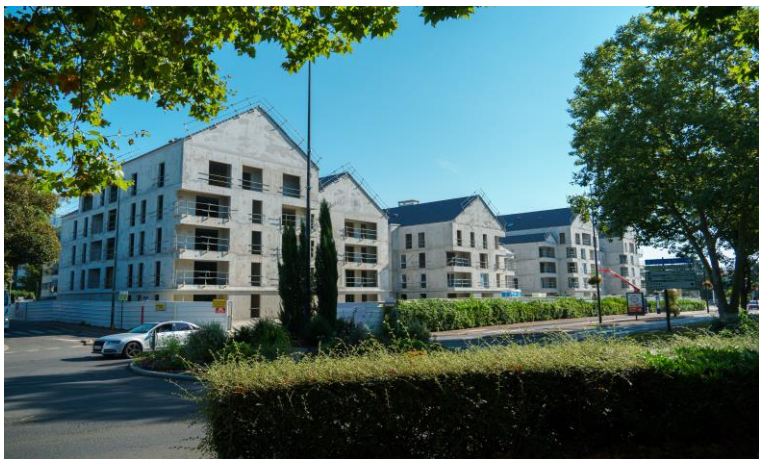
Parc de logements - Saint-Leu-la-Forêt GCC
