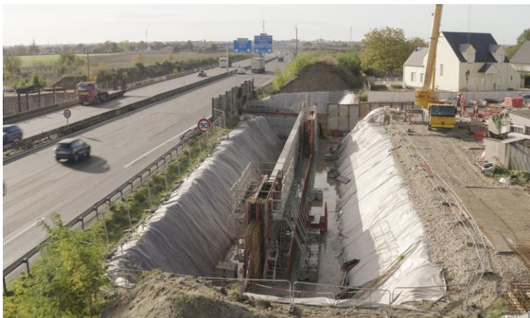
Mur en Béton Matricé – Chantier A10 BOUYGUES
