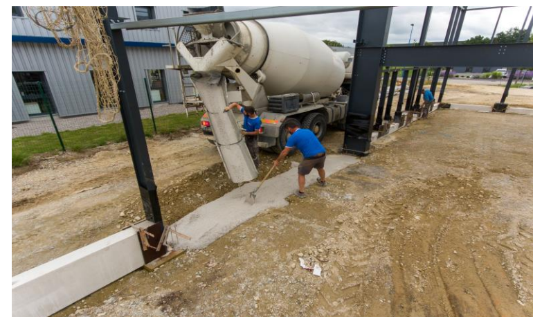
Fondations pour le bâtiment industriel SCI Marle
