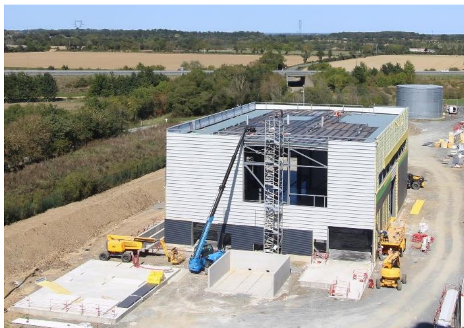
Installation pilote d'Isover
