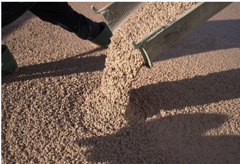
Coulage d'une dalle en béton d'argile décarboné 0% clinker H-EVA
