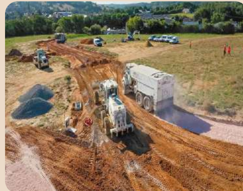
Coulage d'H-EVA en partenariat HRC à Vibraye (72)
