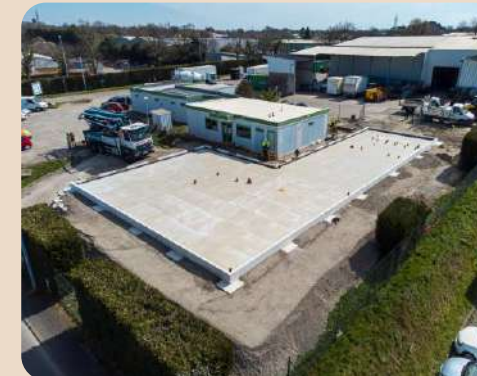
Coulage Dalle au siège du Trait d'Union (85)
