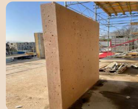
Coulage d'H-EVA en partenariat avec Bouygues Construction et Chryso (49)
