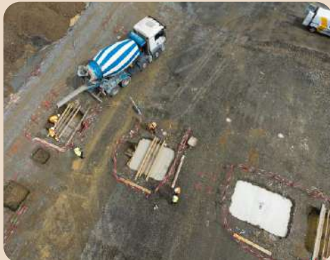
Coulage en partenariat avec Eiffage et Isover (49)
