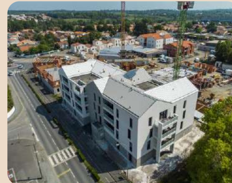
Chantier Duret à Montaignu (85)
