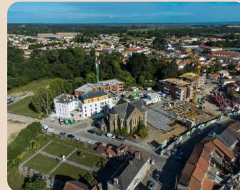
Chantier le Clos Saint-François Saint-Philibert de Grand Lieu (44)
