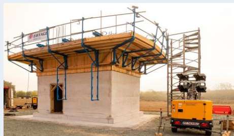
Coffrage glissant EIFFAGE GC
