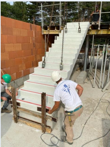
Escaliers LG Béton – Les Hauts de Tanchet
