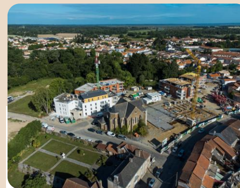
Chantier le Clos Saint- François Saint-Philibert de Grand Lieu
